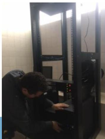
Una vez terminado el trabajo en conjunto con el proveedor, el área de Informática se encarga de realizar el montaje de servidores, instalación y cableado de equipos de cómputo con las pruebas de enlaces y conexiones a los sistemas de cobro y respaldo, configuración e instalación de aparatos telefónicos, así como las pruebas de funcionalidad de los mismos.
