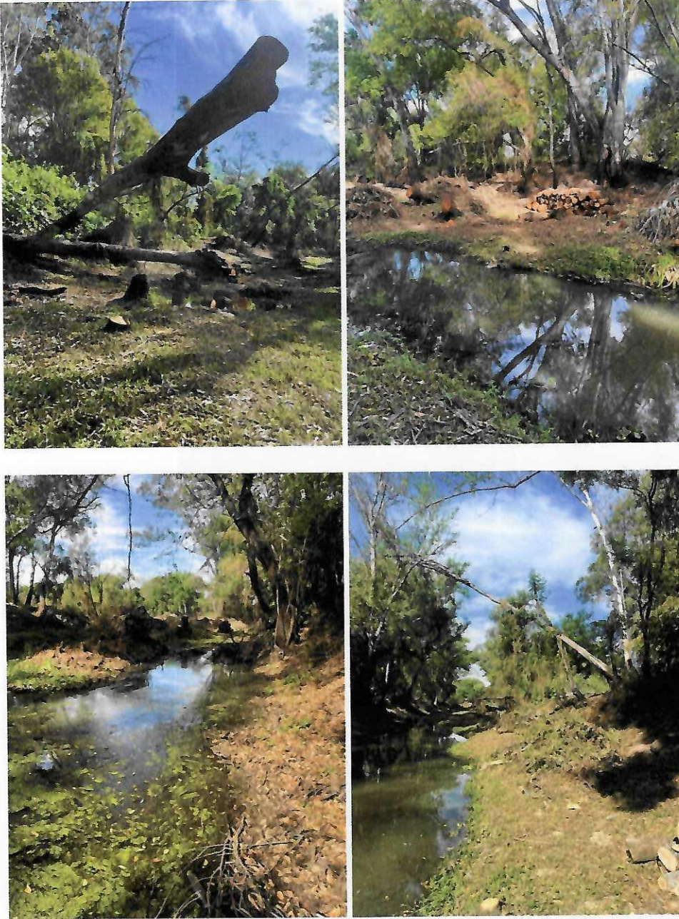
Imágenes 5-8. Ejecución de la primera etapa de mantenimiento preventivo: limpieza del cauce, retiro de sedimentos y material vegetal obstructor.
